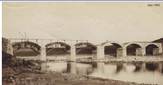
Construcción del Puente Nuevo
